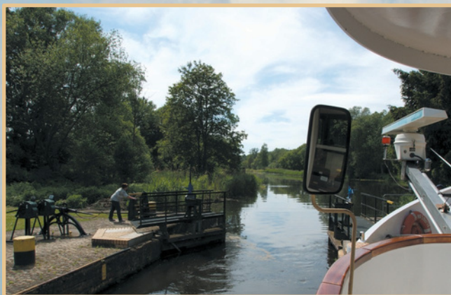
Handbediente Schleuse auf dem Finowkanal
